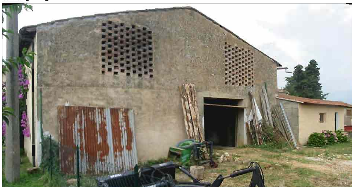
Foto prospetto Nord-Est
